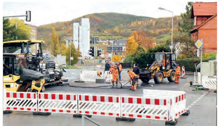
Eine der am häufigsten frequentierten Kreuzungen an einer Kreisstraße wurde jetzt saniert: die Kreuzung an der Schwarzbürger Straße in Rudolstadt-Schwarza. Durch das hohe Verkehrsaufkommen waren massive Schäden am alten Fahrbelag aufgetreten. Ende Oktober erfolgte die Aufbringung der neuen Fahrbelagdecke.
